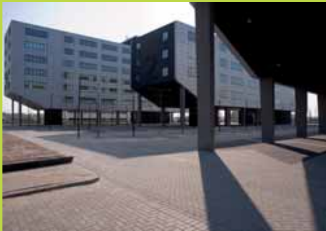
Waalhaven Oost: Dockworks
